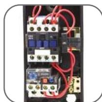
В корпусе пускателя закреплены контактор КМЭ и тепловое реле ПТЭ в сборе
