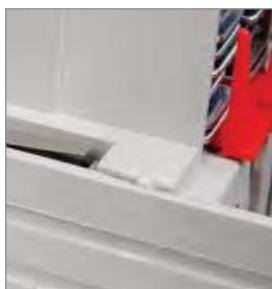
Установленный дополнительный контакт сигнализирует о положении съемной крышки.
