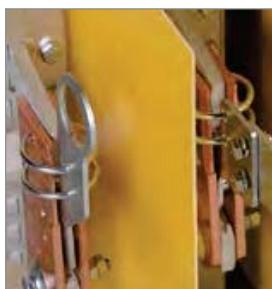
Контактная система ножевого типа обеспечивает видимый разрыв цепи.
