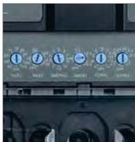
6 регулировок – для любого типа нагрузки и обеспечения селективности двух последовательно включенных устройств. Позволяют осуществлять селективную защиту сетей путем установки различных задержек по времени: наименьшей у потребителя и возрастающей к источнику питания.
