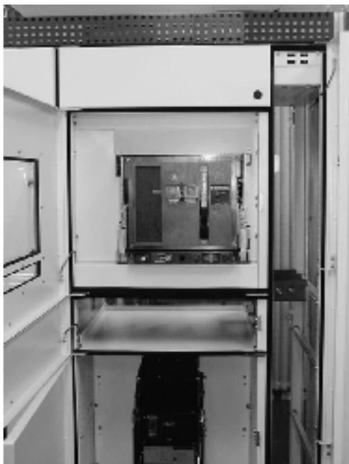
Согласно требованиям проекта распределительных устройств Blokset обладают степенью защиты IP54. Чтобы обеспечивать различную степень защиты оболочки по IP в определенных положениях ячейки, используется прокладка. Прокладка может повредиться в результате старения клея, а также из-за частой эксплуатации некоторых деталей. Отсутствие или деформация прокладки может привести к нарушению защиты от проникновения пыли и влаги.
