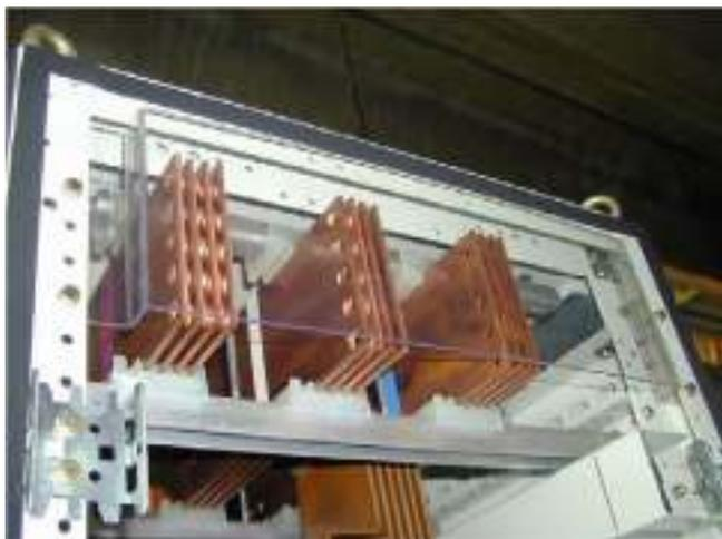
Изоляционные материалы обеспечивают изоляцию проводников между фазами, чтобы выдерживать кратковременное перенапряжение. Избыточное накопление пыли на изолирующих материалах может вызвать частичные разряды, которые, в конечном счете, могут вызвать поверхностный пробой изоляции или внутренний дуговой разряд.
