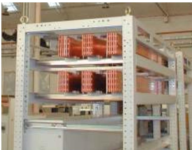
Горизонтальная сборная шина на токи свыше 4000 А состоит из двух стандартных шин, установленных одна над другой.
