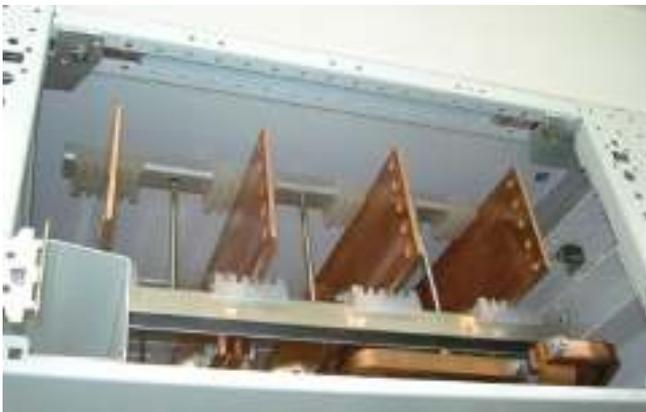
Горизонтальная сборная шина может быть установлена как в верхней, так и в нижней части шкафа. Предусмотрены отверстия для соединения с любыми расширениями в будущем.
