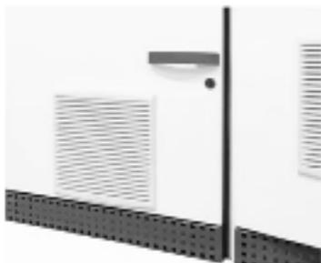
Вентиляция ячейки важна для эффективной работы сборных шин и устройств. Если вентиляционные каналы закупориваются пылью или другими посторонними веществами, это может повлечь за собой серьезное ухудшение эксплуатационных характеристик сборных шин и устройств. Фильтры вентиляторов и вентиляционные решетки необходимо очищать, чтобы обеспечить циркуляцию воздуха в шкафу во избежание перегрева.
